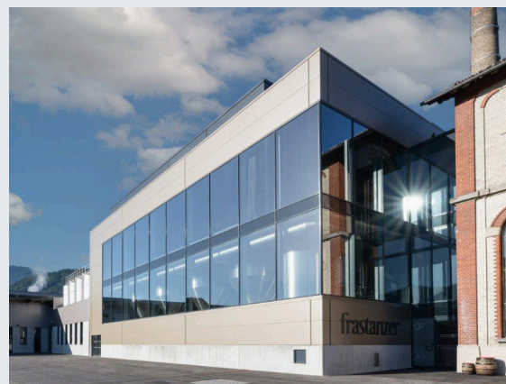
Außenansicht der neuen Brauerei Frastanz mit Gär- und Biolagerkeller im Vordergrund. Bild: Brauerei Frastanz eGen
